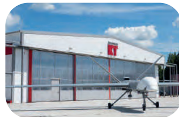
Завод Кронштадт, г. Москва
