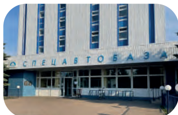
ГУП Водоканал, г. Санкт-Петербург
