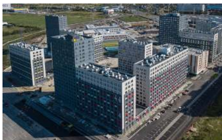
г. Тюмень, ЖК «Звездный» Счетчики воды квартирные – 1 368 шт. Теплосчетчики квартирные – 690 шт.
