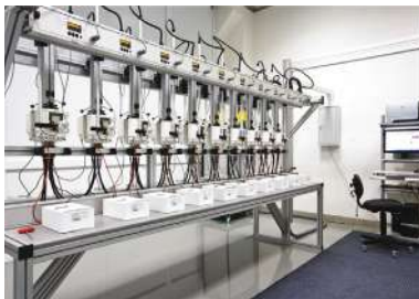
Стенд поверки и тестирования электросчетчиков
