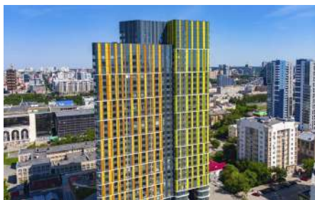
г. Москва, ЖК «Тринити» Счетчики воды квартирные – 2 680 шт. Теплосчетчики квартирные – 2 212 шт.
