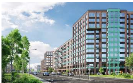
г. Санкт-Петербург, ЖК «Svetlana Park» Электросчетчики «Пulsар 1Т» – 510 шт. Электросчетчики «Пulsар 3» – 580 шт.
