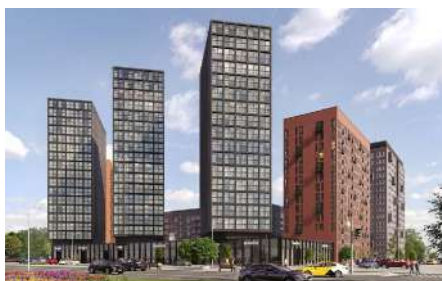
Тюменская обл., д. Дударева, ЖК «Андерсен Парк» Счетчик воды квартирные – 929 шт. Теплосчетчики квартирные – 452 шт.
