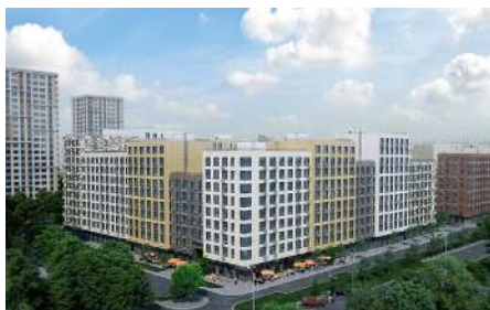
г. Москва, ЖК «LIFE-Варшавская» Счетчик воды квартирные – 5 976 шт. Теплосчетчик квартирные – 1 158 шт.
